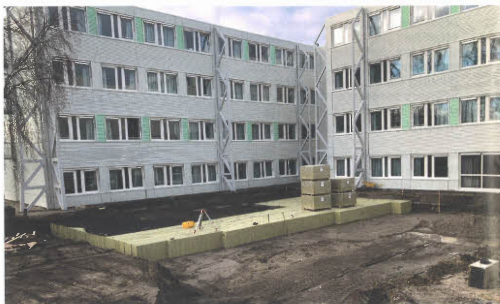
Bij een project aan de Kruislaan in Amsterdam is gekozen voor een ondergronds systeem om tijdelijk hemelwater te kunnen bufferen.
